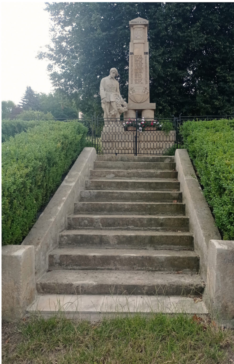
UKÁZKA ZDAŘILÉ RESTAURACE POMNÍKU
